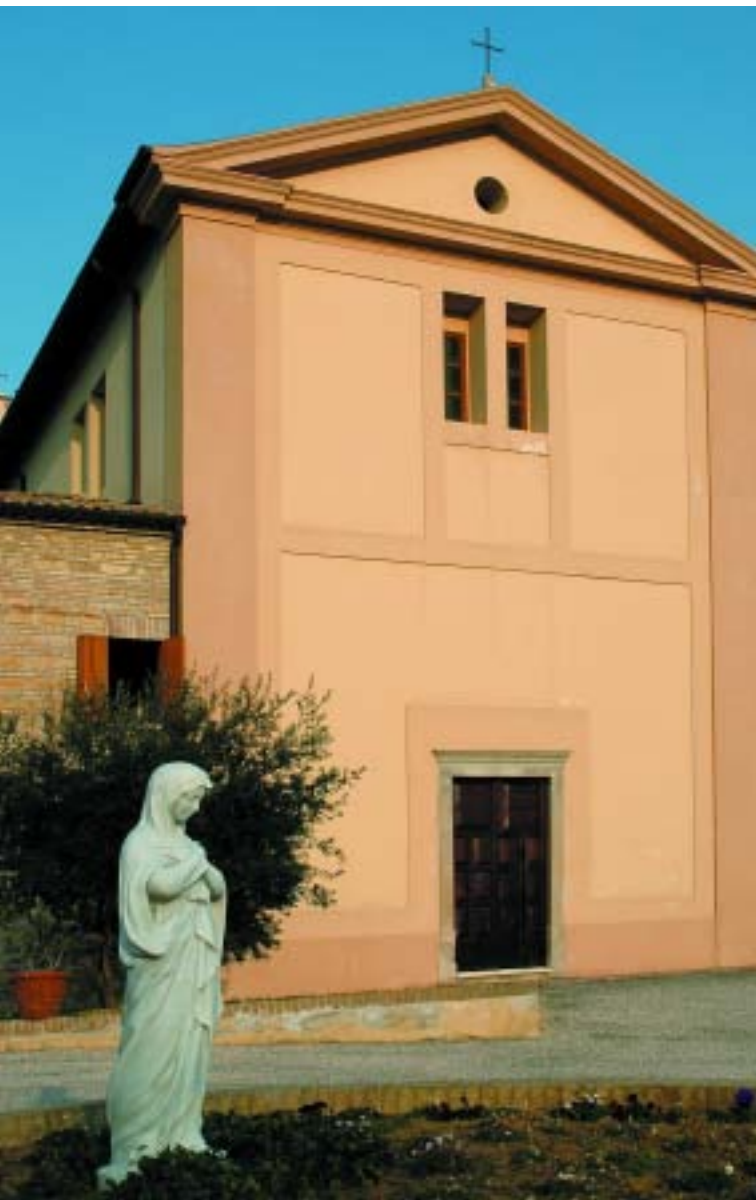
La facciata della chiesa In copertina: Sebastiano Ceccarini, S. Giovanni della croce
