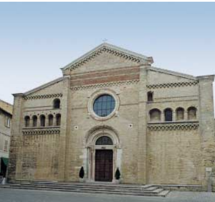
Facciata della Cattedrale di Fano
