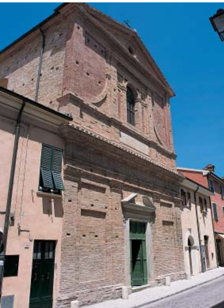
Facciata della Chiesa, 1610
