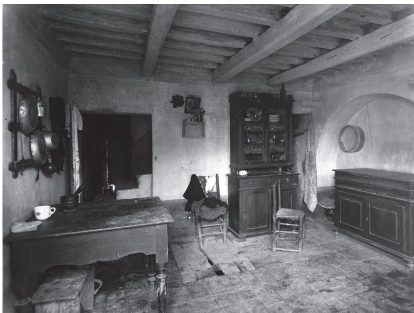
Fano, interno di una casa del quartiere Piattelletti
