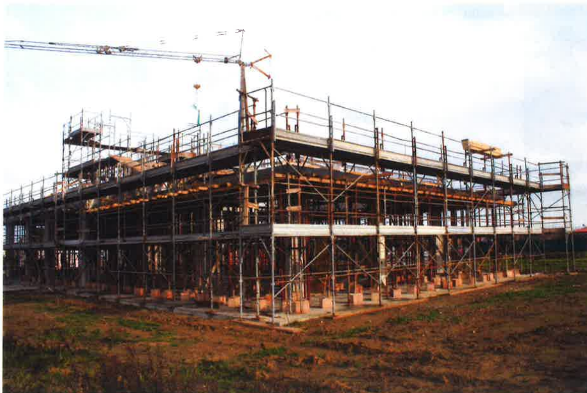
foto del centro in corso di costruzione
